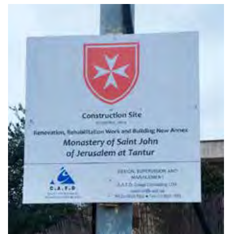
Nelle foto, una parte dei lavori in corso d'opera.
